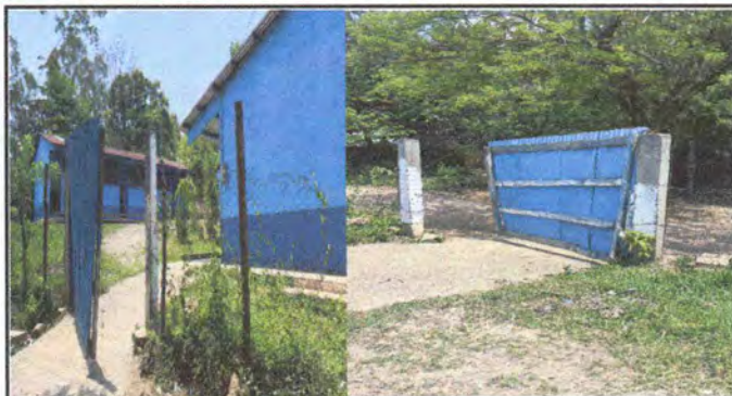
Foto 2: FABRICACIÓN E INSTALACIÓN DE PORTÓN DE INGRESO
