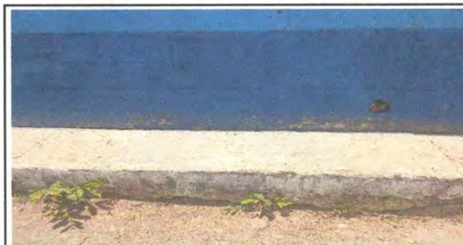
Foto 11: REPARACIÓN DE BANQUETA LADO IZQUIERDO
