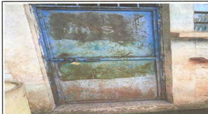
Foto 4: REPARACIÓN DE PUERTA DE BAÑO HOMBRES
