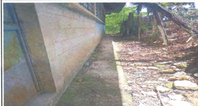
Foto 9: REPARACIÓN DE BANQUETA PARTE DE ATRÁS
