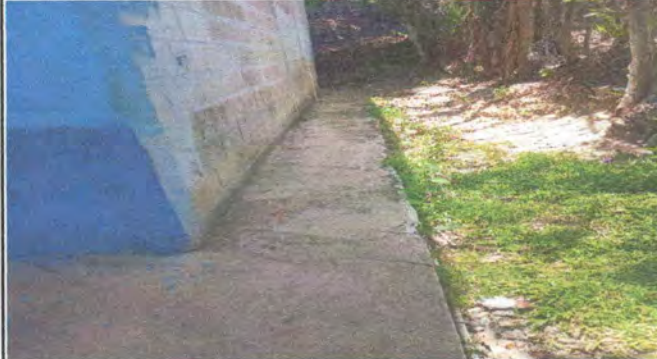
Foto 10: REPARACIÓN DE BANQUETA LADO DERECHO
