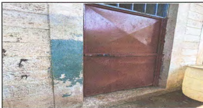
Foto 5: REPARACIÓN DE PUERTA DE BAÑO DE MUJERES
