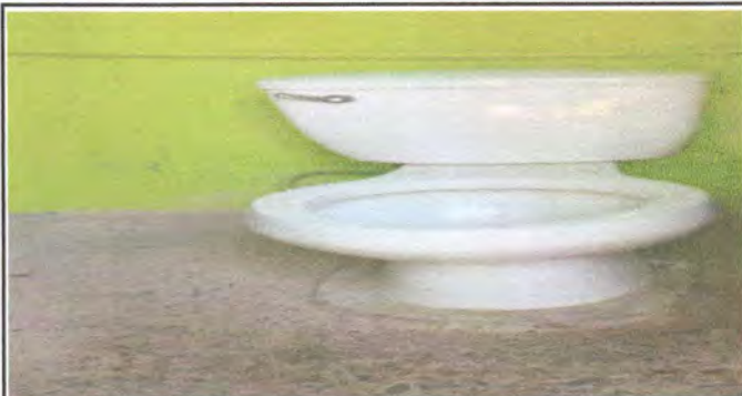
Foto 7: SUSTITUCIÓN DE INODORO DE HOMBRES
