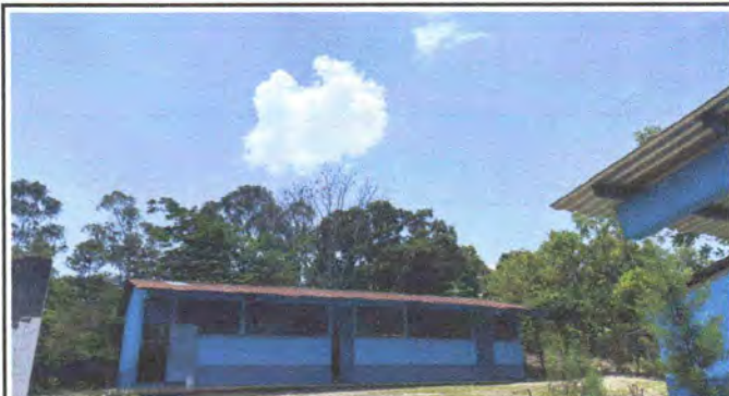
Foto 1: CUBIERTA DE LAMINA
