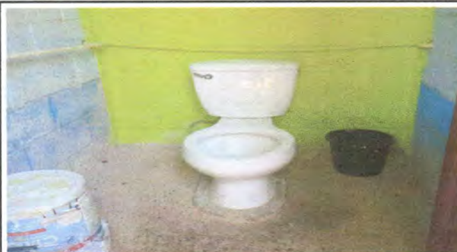
Foto 8: SUSTITUCIÓN DE INODORO DE MUJERES
