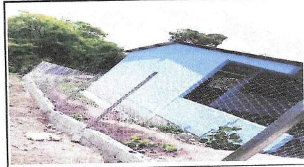
Foto 4: PINTURA EN MUROS EXTERIORES E INTERIORES
