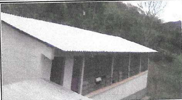
Foto 1: CUBIERTA DE LAMINA
