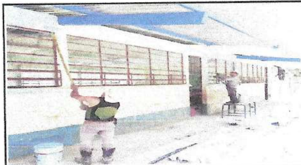
Foto 4: PINTURA EN MUROS EXTERIORES E INTERIORES
