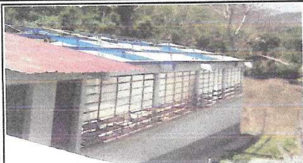
Foto 1: CUBIERTA DE LAMINA
