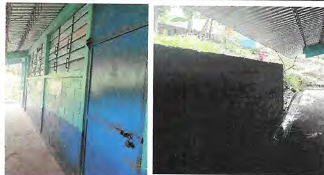
Foto 2: PINTURA EN MUROS
