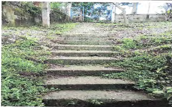
Foto 1: REPARACION DE DAÑOS EN PATIO
