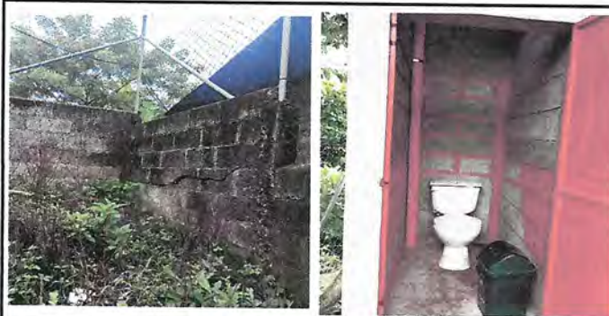
Foto 6: REPARACION DE MURO PERIMETRAL Y BAÑOS
