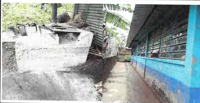
Foto 5: REPARACION DE COCINA Y PINTURA
