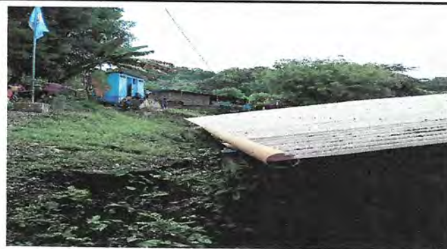
Foto 4: REPARACION DE CANAL
