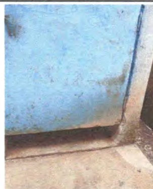
Foto 4: PUERTAS DE SANITARIO
