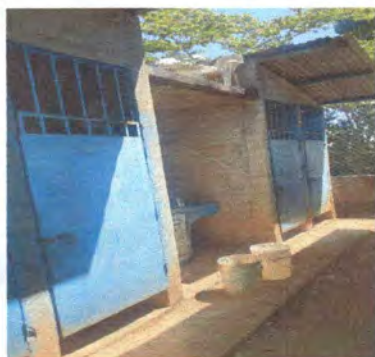
Foto 3: PUERTAS DE SANITARIO
