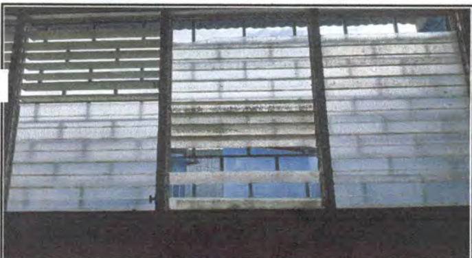
Foto 3: Mantenimiento de ventanas.
