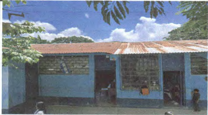
Foto 1: Retoque de pintura en aulas interiores y exteriores.
