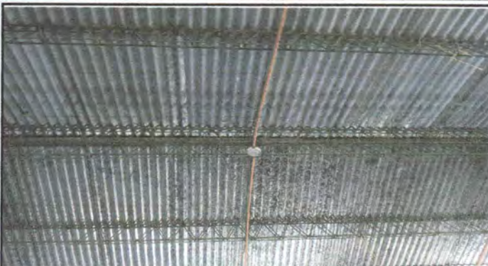
Foto 2: Sustitución de lamina y costaneras en aulas ya que se encuentran en mal estado.
