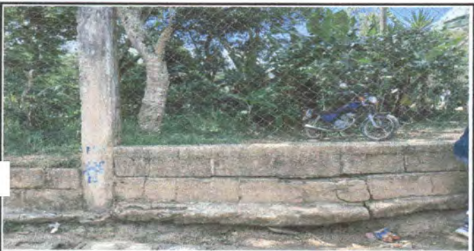
Foto 5: Demolición de muro perimetral que se encuentra en mal estado.
