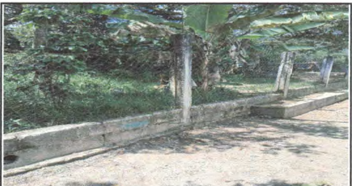
Foto 6: Reparación de muro.
