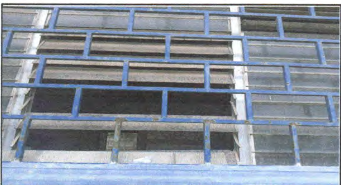
Foto 4: Sustitución de vidrios quebrados en ventanales.
