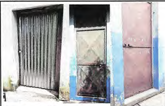
Foto 1: FABRICACIÓN DE PUERTAS Y MANTENIMIENTO PARA TRES PUERTAS
