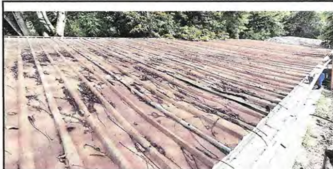
Foto 2: SUSTITUCIÓN DE LAMINA TROQUELADA Y DE LA ESTRUCTURA
