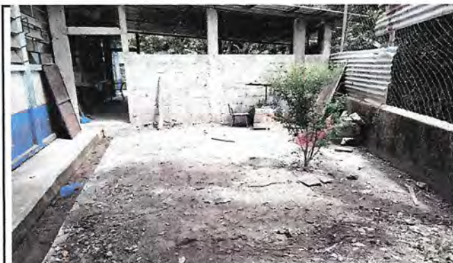
Foto 3: REMOZAMIENTO DE LOSA DE PATIO
