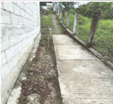
Foto 5: REPARACIÓN DE CUNETA DE CONCRETO ✓
