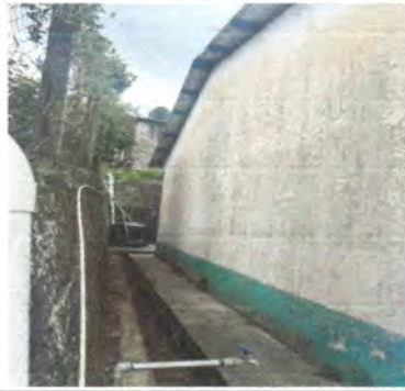
Foto2: PINTURA EN MUROS EXTERIORES E INTERIORES
