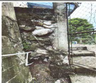
Foto 2: REPARACIÓN DE MURO DE CONTENCIÓN
