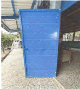
Foto 1: MANTENIMIENTO O ESTRUCTURA (PUERTAS) ✓
