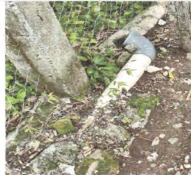
Foto 4: SUSTITUCIÓN DE TUBERÍA PVC LÍNEA PRINCIPAL AGUA PLUVIALES 6 PLG
