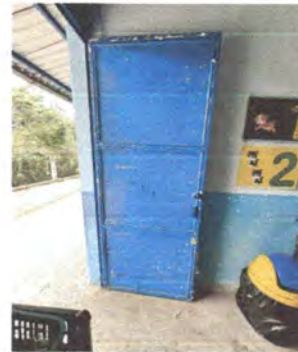
Foto 2: MANTENIMIENTO O ESTRUCTURA (PUERTAS)
