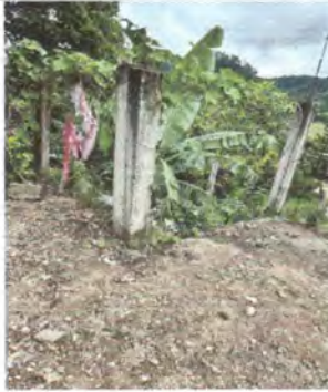
Foto 1: REPARACIÓN DE MURO DE BLOCK
