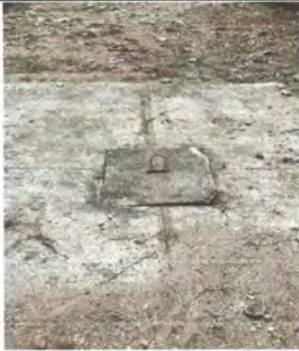
Foto 3: REPARACIÓN DE PLANCHA DE CONCRETO DE PATIO
