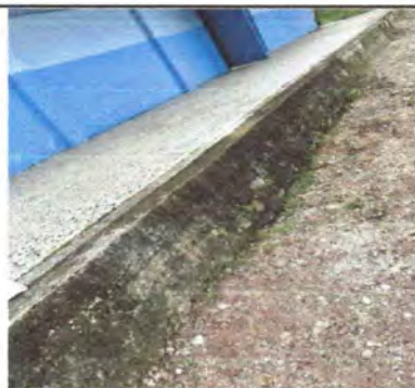
Foto 4: APLICACIÓN DE SABIETA DE MURO DE CONTENCIÓN
