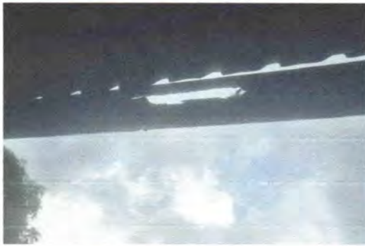
Foto 3: SUSTITUCIÓN DE CANAL DE METAL
