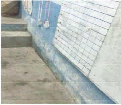
Foto1: PINTURA EN MUROS EXTERIORES E INTERIORES
