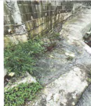
Foto 4: REPARACIÓN DE PLANCHA DE CONCRETO DE PATIO
