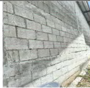
Foto 6: REPELLO EN MURO
