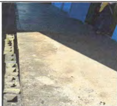
Foto 3: REPARACIÓN DE MURO DE CONTENCIÓN
