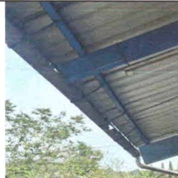
Foto 4: SUSTITUCIÓN DE CANAL DE METAL
