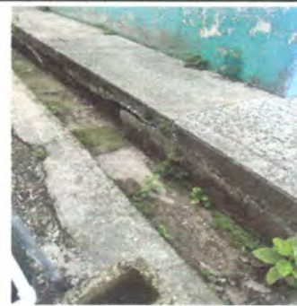
Foto 6: REPARACIÓN DE BANQUETA DE CONCRETO ✓
