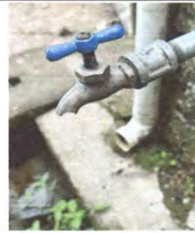
Foto 6: SUSTITUCIÓN DE LLAVE DE CHORRO
