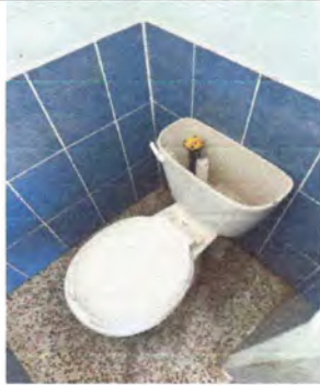
Foto 3: SUSTITUCIÓN DE INHODORO
