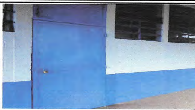
Foto 2: PUERTAS DE METAL
