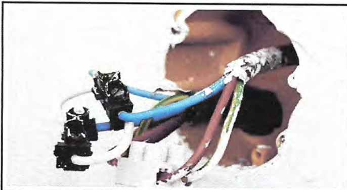
Foto 3: REPARACION DE SISTEMA ELÉCTRICO
