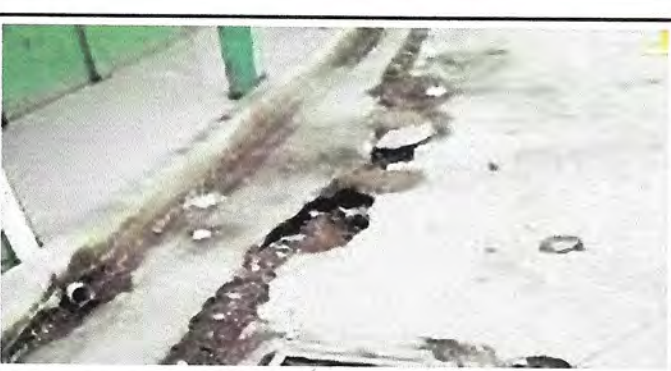
Foto 6: CUNETETA DE CONCRETO
