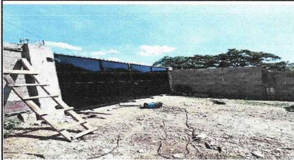
Foto 1: SUSTITUCIÓN DE PORTON
