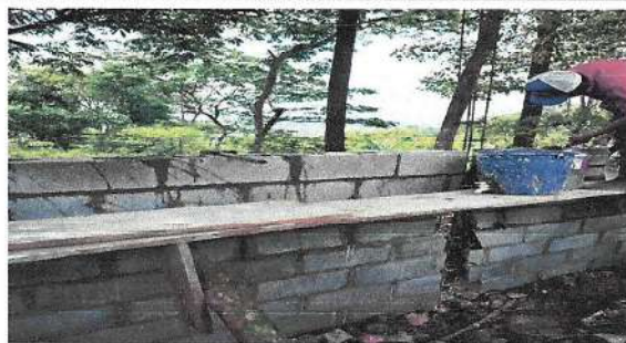
Foto 3: SEGUIMIENTO DE MURO PERIMETRAL CON BLOCK
