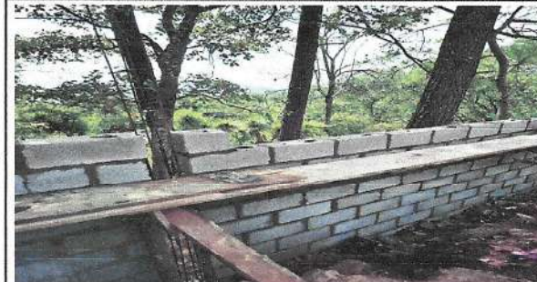
Foto 4: SEGUIMIENTO DE MURO PERIMETRAL CON BLOCK
