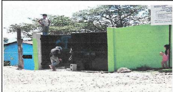
Foto 2: SUSTITUCIÓN DE PORTON
