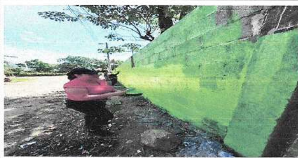
Foto 5: PINTADO DEL MURO EXTERIOR 50M
