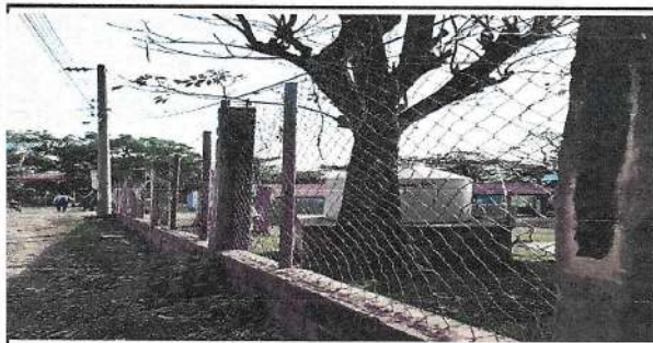
Foto 5: PINTADO DEL MURO EXTERIOR 50M
