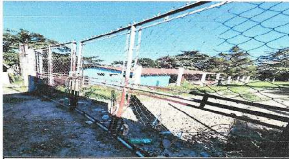
Foto 1: SUSTITUCIÓN DE PORTON
