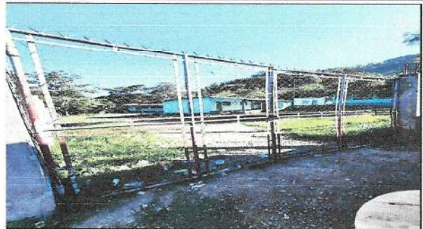
Foto 2: SUSTITUCIÓN DE PORTON
