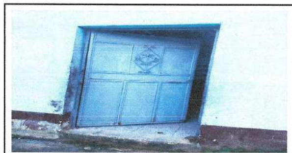
Foto 6: SUSTITUCIÓN DE CHAPA
