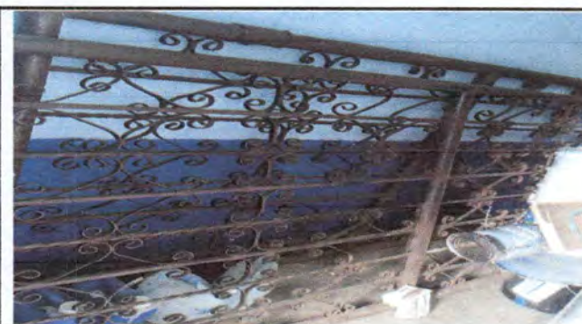
Foto 4: porton de entrada
