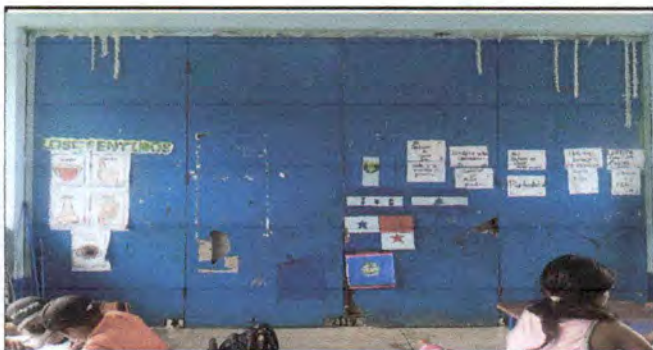
Foto 3: Sustitucion de portones de madera por metal para dividir salones de clase
