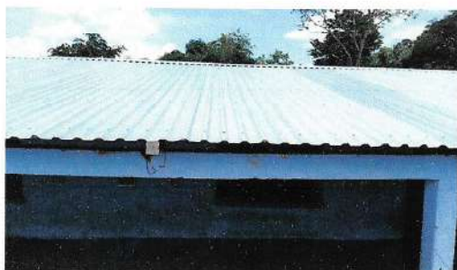
Foto 1: Sustrución de lamina, por lámina troquelada.
