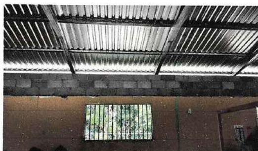
Foto 3: levantado de pared de techo.
