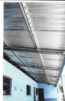
Foto 2: sustitución de estructura de soporte de madera, por metal.
