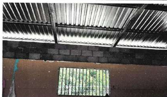
Foto 4: levantado de pared de techo.
