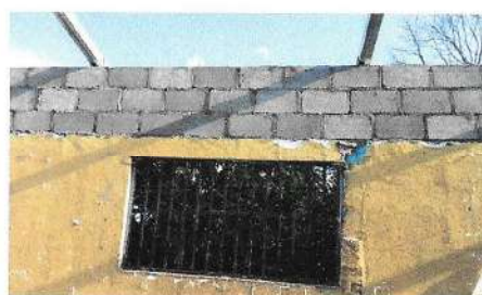
Foto 4: levantado de pared de techo.
