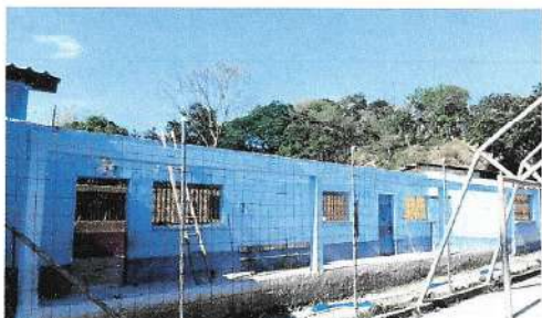
Foto 1: Sustrucción de llamina, por lámina troquelada.
