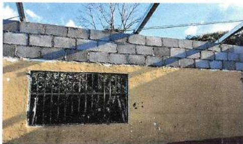
Foto 3: levantado de pared de techo.
