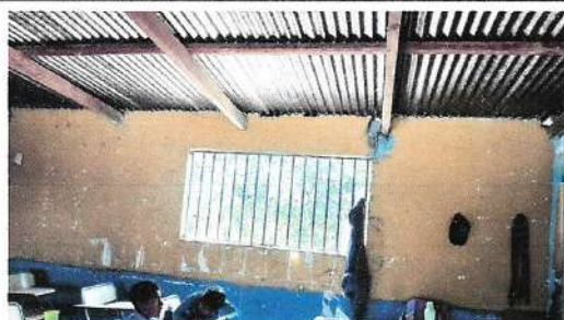
Foto 3: levantado de pared de techo.
