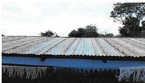
Foto1: Sustitución de lamina, por lámina troquelada.
