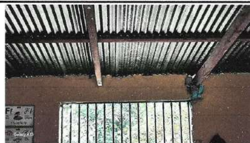
Foto 4: levantado de pared de techo.
