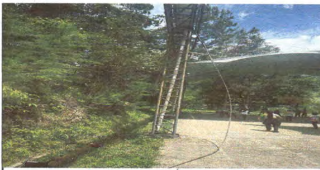
SUSTITUCIÓN DE ESTRUCTURA METÁLICA
