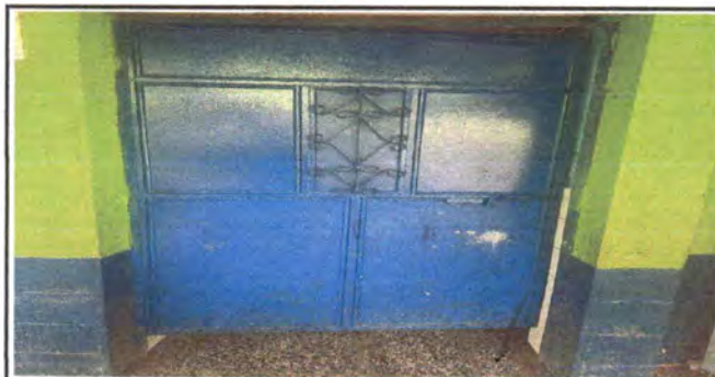
SUSTITUCIÓN DE PINTURA
