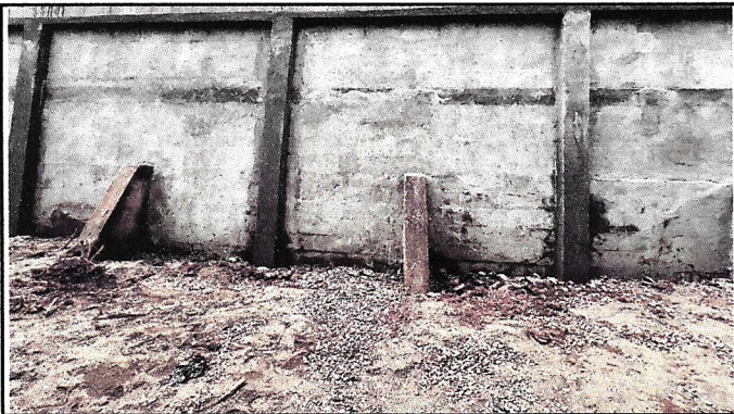
Foto1: Columnas fundidas de manera correcta.
