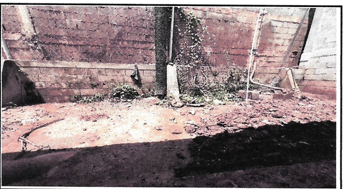
Foto 6: Reforzamiento de muro perimetral, para brindar mejor seguridad al bienestar de los alumnos y personal docente.
