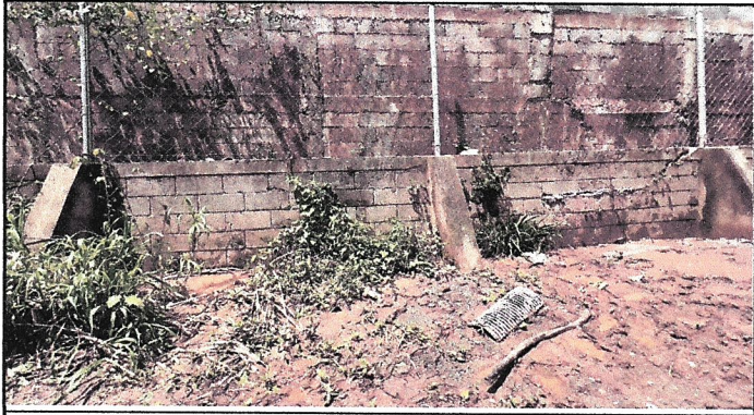
Foto1: Reforzamiento de muro perimetral, para brindar mejor seguridad al bienestar de los alumnos y personal docente .
