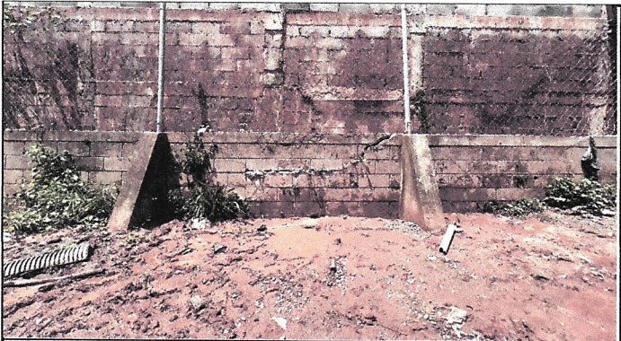
Foto 3: Reforzamiento de muro perimetral, para brindar mejor seguridad al bienestar de los alumnos y personal docente ..
