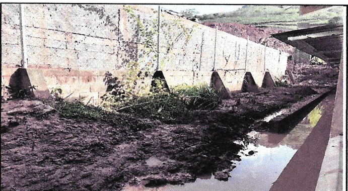
Foto 4: Reforzamiento de muro perimetral, para brindar mejor seguridad al bienestar de los alumnos y personal docente .
