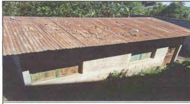
Foto 5: techo de la escuela
