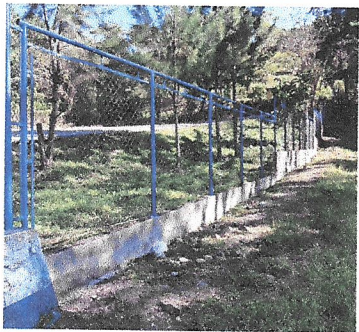
Foto 3: trabajo finalizado de la malla parimetral
