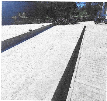
Foto1: trabajo finalizado de losa de patio
