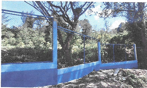
Foto 4: finalización del trabajo del muro parimetral
