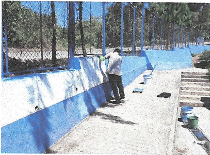
Foto 6: mejoramiento de pintura
