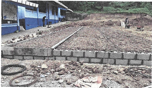
Foto1: trabajo de mejoramiento de losa de patio
