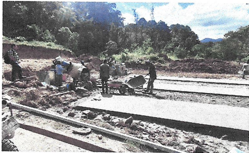
Foto 2: Trabajo de mejoramiento de losa de patio
