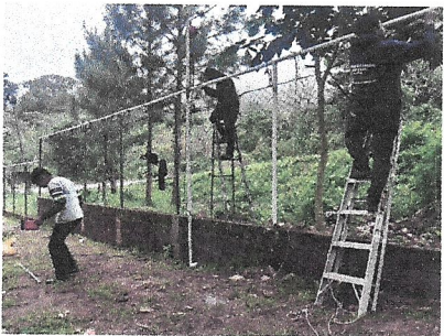
Foto 3: trabajos de mejoramiento de malla perimetral
