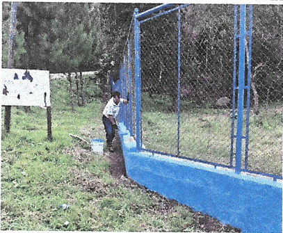
Foto 5: Mejoramiento de pintura
