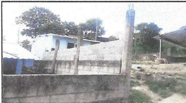
Foto 2: Reparación de muro de constención
