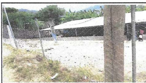
Foto 10: Reparacion de mayagalvanizada en muro perimetral
