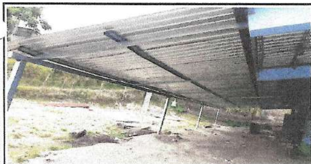
Foto 11: Sustruccion de estructura de soporte de metal metal
