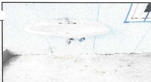
Foto 5: Sustitución de lavamanos
