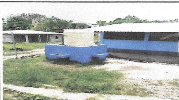
Foto 7: Sustruccion de deposito de agua
