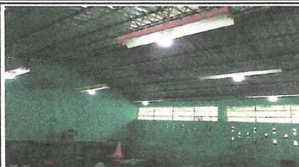
Foto 8: sustitucion de focos ahorradores
