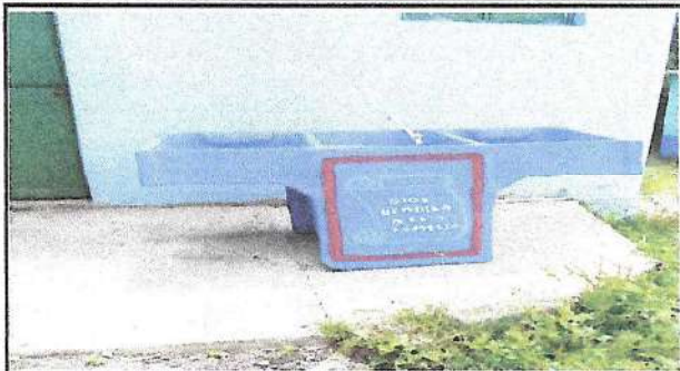
Foto 1: Sustitución de pila de dos lavaderos
