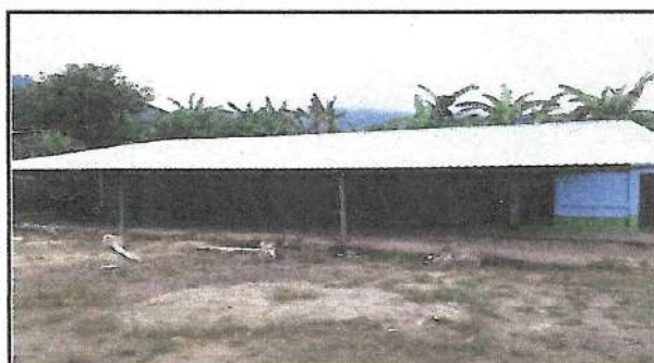
Foto 4: Sustitución de lamina troquelada
