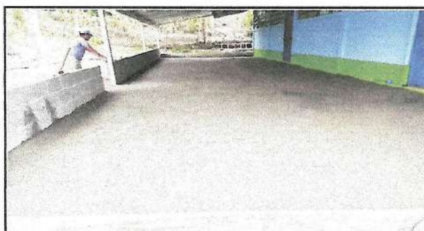
Foto 3: Reparación de piso torta de cemento
