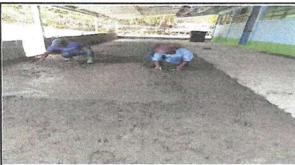
Foto 3: Reparación de piso torta de cemento
