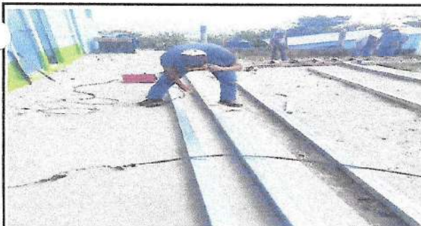
Foto 11: Sustitución de estructura de soporte de metal
