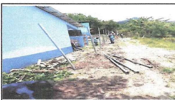
Foto 10: Reparación de mayagalvanizada en muro perimetral
