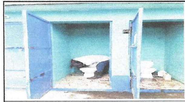
Foto 6: Sustrucción de baños
