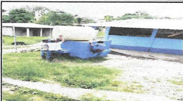
Foto 7: Sustitución de depósito de agua
