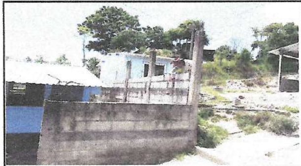
Foto 2: Reparación de muro de constención
