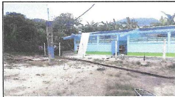
Foto 4: Sustrucción de lámina troquelada
