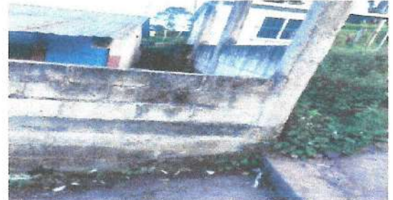
Foto 2: Reparación de muro de contención
