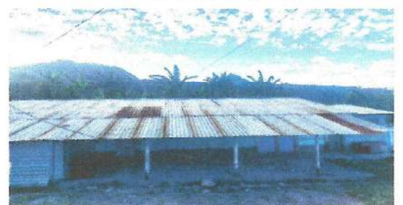
Foto 4: Sustitución de lámina troquelada
