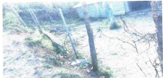
Foto 10: Reparacion de mayagalvanizada en muro perimetral
