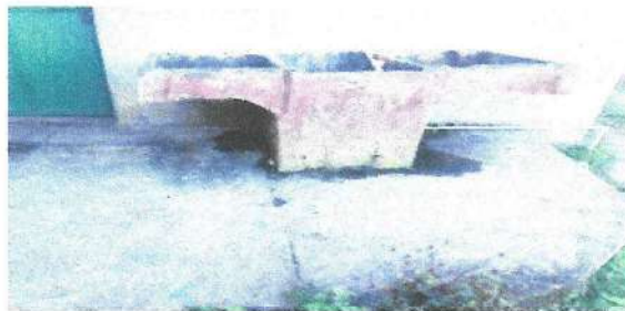
Foto 1: Sustitución de pila de dos lavaderos
