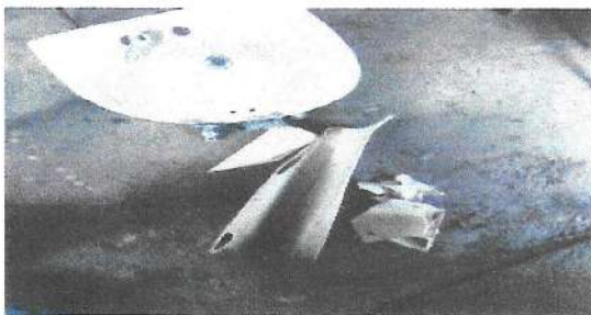
Foto 5: Sustitución de lavamanos
