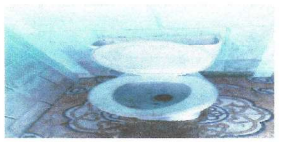
Foto 6: Sustitución de baños
