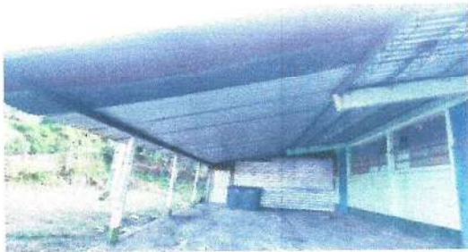
Foto 11: Sustitucion de estructura de soporte de metal metal
