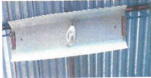
Foto 8: sustitucion de focos ahorradores
