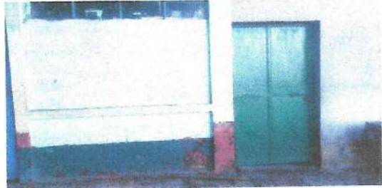
Foto 12: pinturas en muros exteriores e interiores
