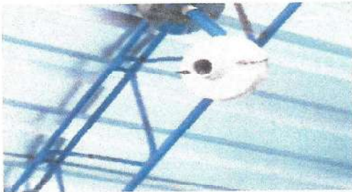
Foto 9: Sustitucion de plafoneras
