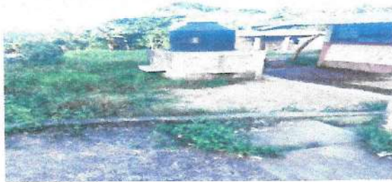
Foto 7: Sustitución de depósito de agua
