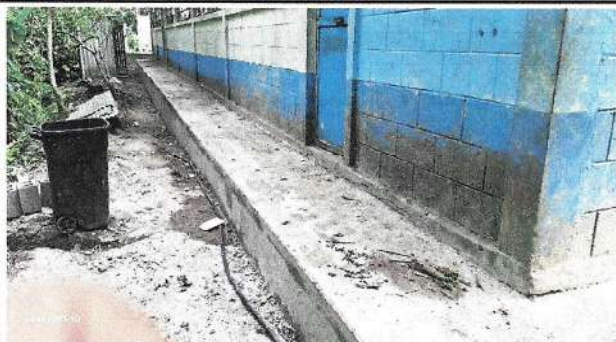
Foto 1: Reparación de banquetas de concreto, en la parte de atrás de la escuela.
