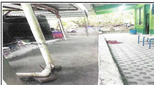
Foto 6: Reparación de piso de torta de concreto
