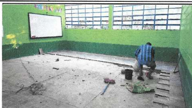
Foto 2: Sustitución de piso de torta cemento, por piso cerámico.
