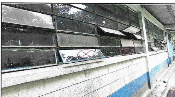
Foto 3: Sustitución de vidrios, dañados en los ventanales de la escuela
