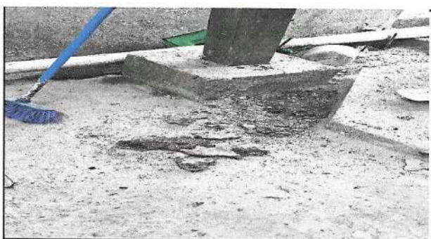
Foto 6: Reparación de piso de torta de concreto
