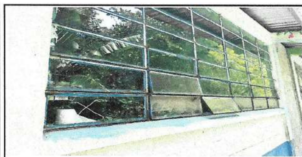
Foto 3: Sustitución de vidrios, dañados en los ventanales de la escuela
