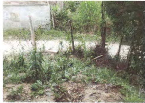
Foto 2: REPARACIÓN DE MURO PERIMETRAL
