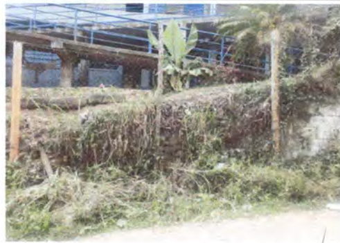
Foto 4: REPARACIÓN DE MURO PERIMETRAL
