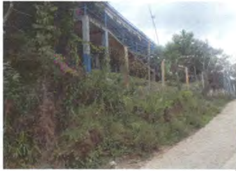
Foto 1: REPARACIÓN DE MURO PERIMETRAL
