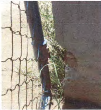
Foto 3: MANTENIMIENTO DE PORTONES DE METAL
