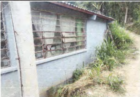
Foto 5: REPARACIÓN DEL MURO PERIMETRAL
