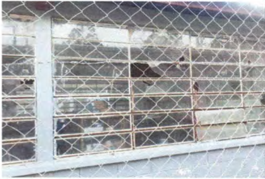
Foto 1: SUSTITUCIÓN DE VENTANAS
