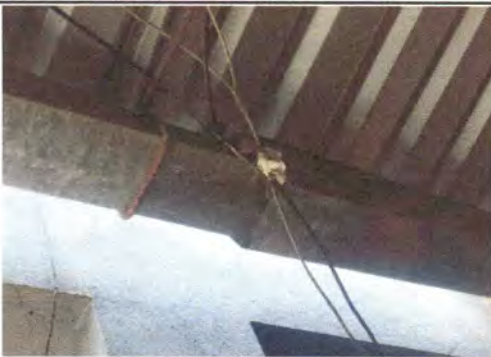
Foto 3: SUSTITUCIÓN DE CANAL DE METAL
