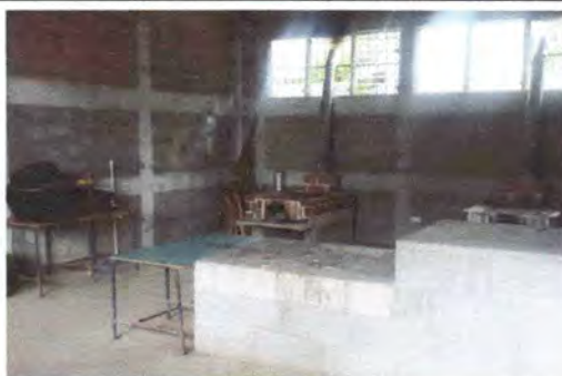
Foto 3: INSTALACIÓN DE AZULEJOS EN DESAYUNADOR
