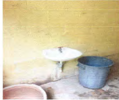
Foto 2: SUSTITUCIÓN DE LAVAMANOS
