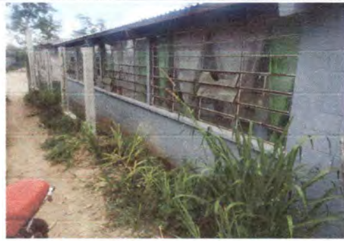
Foto 4: REPARACIÓN DEL MURO PERIMETRAL
