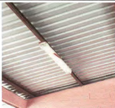
Foto 1: SUSTITUCIÓN DE LÁMPARAS
