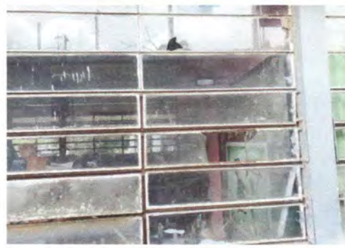
Foto 2: SUSTITUCIÓN DE VENTANAS
