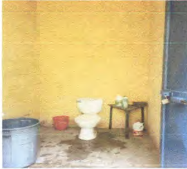
Foto1: MANTENIMIENTO A ESTRUCTURA (BAÑOS)
