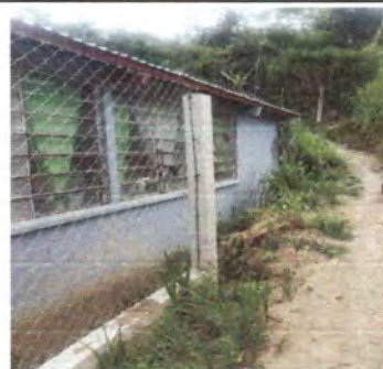
Foto 6: REPARACIÓN DEL MURO PERIMETRAL
