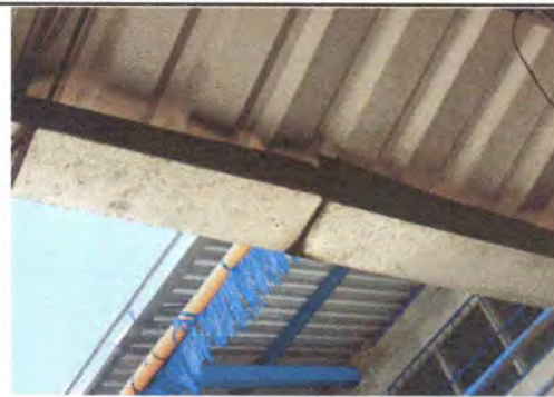
Foto 4: SUSTITUCIÓN DE CANAL DE METAL
