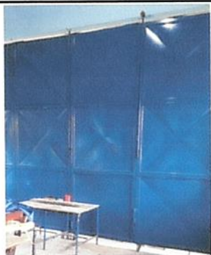
Foto 3: Mantenimiento de puertas.
