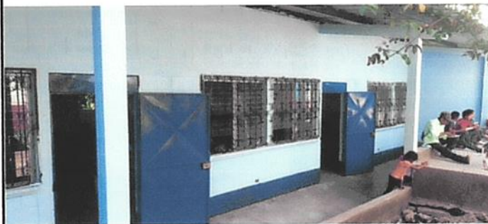
Foto 6: Pintura de muros internos y externos.
