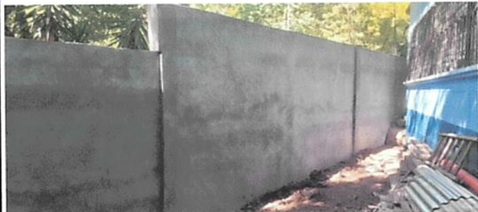
Foto 1: Segumiento y refuerzo de muro perimetral.
