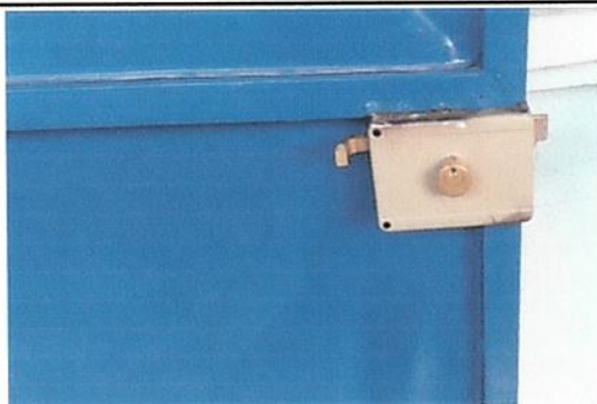
Foto 5: Sustitución de chapa.
