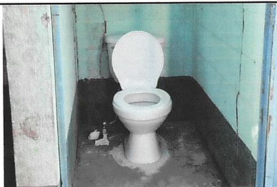
Foto 4: Sustitucion de sanitarios y accesorios.
