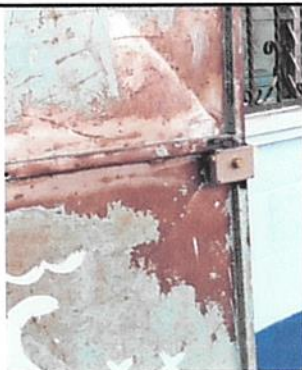
Foto 5: Sustitución de chapa.
