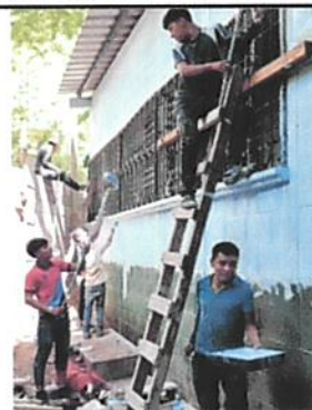
Foto 6: Pintura de muros internos y externos.
