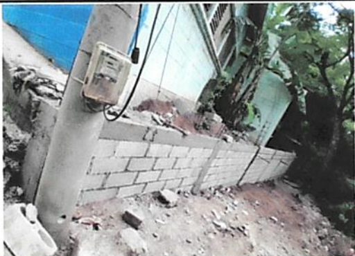
Foto1: Segimiento y refuerzo de muro perimetral.
