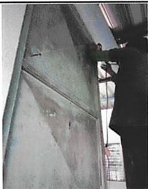
Foto 3: Mantenimiento de puertas.
