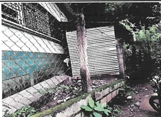
Foto1: Segumiento y refuerzo de muro perimetral.
