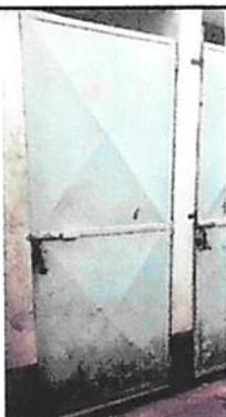
Foto 3: Mantenimiento de puertas.
