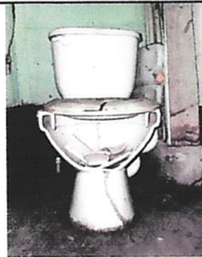
Foto 4: Sustitucion de sanitarios y accesorios.
