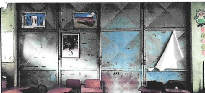
Foto 5: Mantenimiento a puerta.
