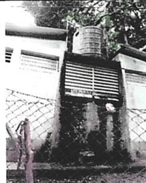
Foto 2: Sustitucion de deposito de agua y accesorios.
