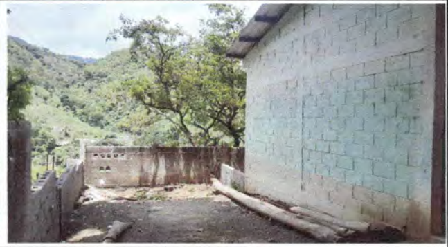
Foto 2: Seguimiento y reforzamiento de pared.
