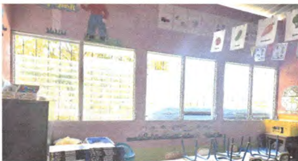
Foto 5: Instalación de ventanas corredizas.
