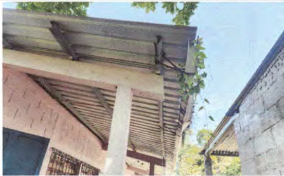
Imagen 3. Instalación de canales.
