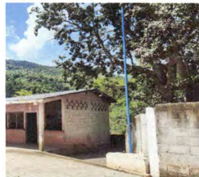
Imagen 4. instalación de piso de losa de patio
