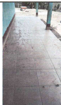
Foto 4: Reparación de piso en aulas.
