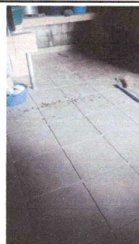
Foto 2: Reparación de piso de cocina.
