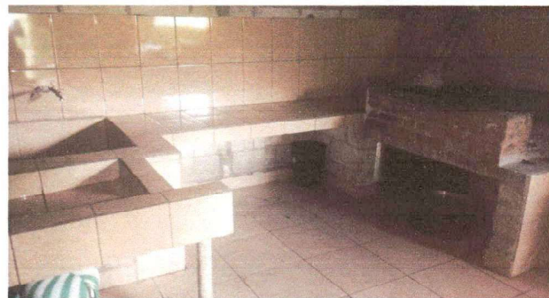
Foto 6: Instalación de azulejo para área de chimenea.
