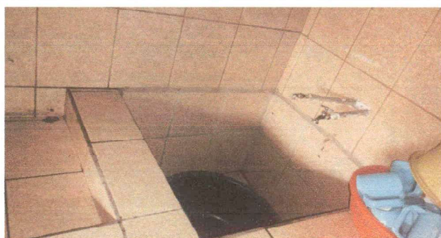
Foto 5: Reparación de pila con azulejo.
