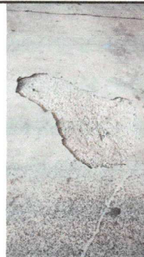
Foto 4: Reparación de piso en aulas.
