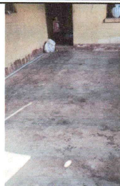
Foto 2: Reparación de piso de cocina.
