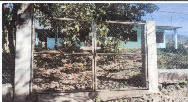
Foto 3: Reparación de muro perimetral.
