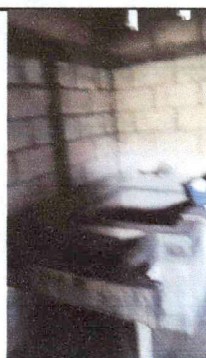
Foto 5: Reparación de pila con azulejo.
