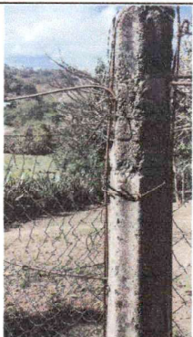
Foto1: Reparación de columnas y malla de muro perimetral.
