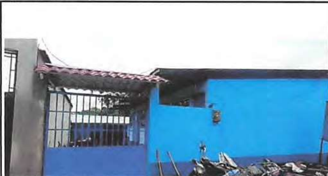
Foto1: Sustrucción de portón e instalación de techo para el mismo., continuación de muro perimetral, cernido y repellido de pared.
