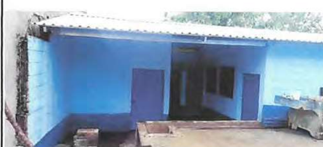
Foto 4: Reparación de estructura metálica, sustitución de lámina, y sustitución de puertas de cocina.
