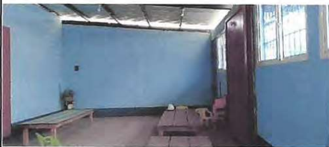
Foto 3: Pintura de muros interior y exterior.
