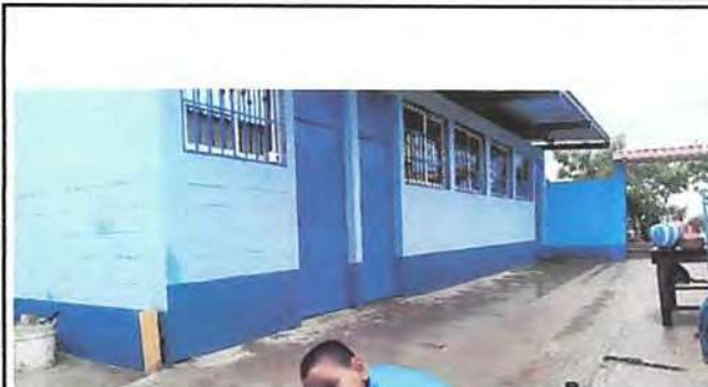
Foto 2: Mantenimiento de puertas y sustitución de ventanas por ventanas de PVC.
