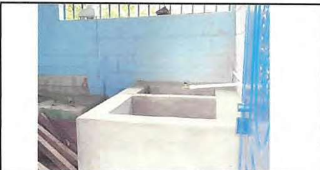
Foto 5: Sustrucción de pila para cocina y pintado de muros interiores.
