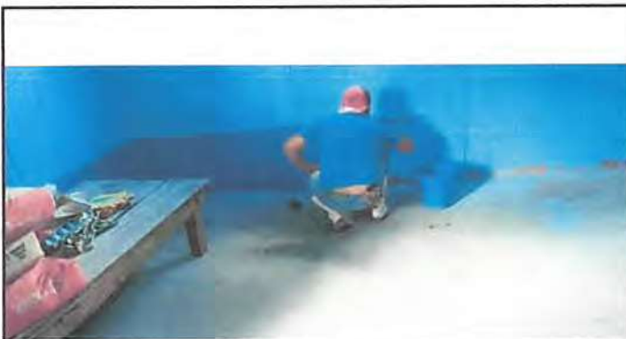
Foto 3: Pintura de muros interior y exterior.
