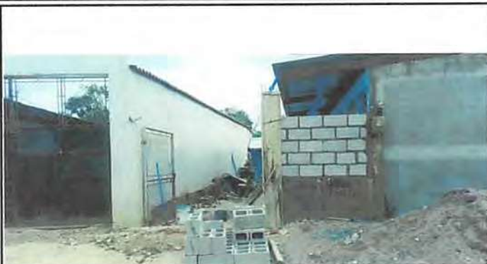
Foto1: Sustitución de portón e instalación de techo para el mismo., continuación de muro perimetral, cernido y repellido de pared.
