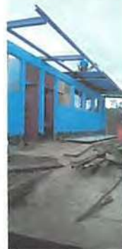
Foto 2: Mantenimiento de puertas y sustitución de ventanas por ventanas de PVC.
