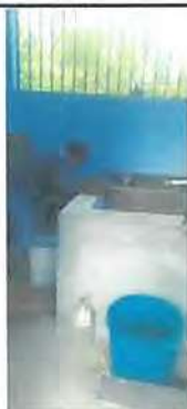
Foto 5: Sustitución de pila para cocina y pintado de muros interiores.
