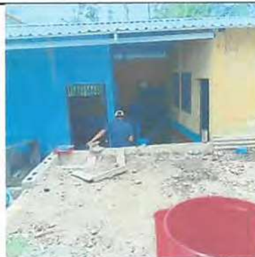
Foto 4: Reparación de estructura metálica, sustitución de lámina, y sustitución de puertas de cocina
