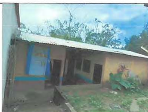
Foto 4: Reparación de estructura metálica, sustitución de lámina, y sustitución de puertas de cocina.
