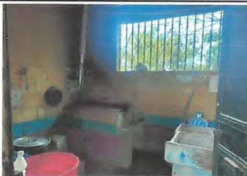
Foto 5: Sustitución de pila para cocina y pintado de muros interiores.
