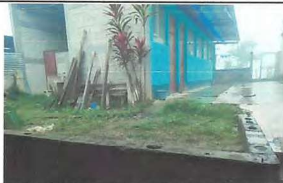
Foto 2: Mantenimiento de puertas, sustitución de ventanas por ventanas de PVC, sustitución de techo.
