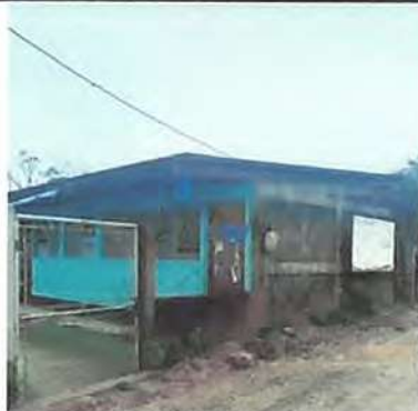
Foto1: Sustitución de portón e instalación de techo para el mismo., continuación de muro perimetral, cernido y repellido de pared.
