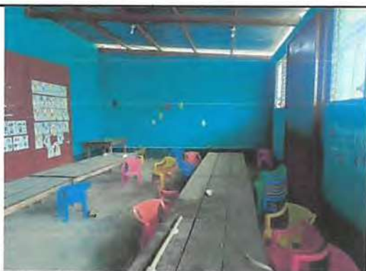
Foto 3: Pintura de muros interior y exterior.
