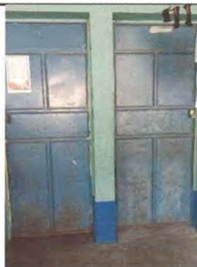
Foto 3: Mantenimiento de puertas y sustitución de chapa.
