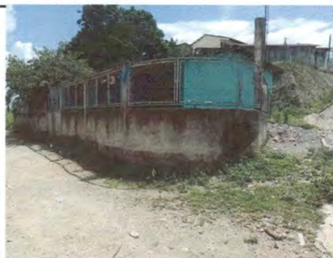
Foto 6: Mantenimiento a barandas (cepillado, lijado y pintado)
