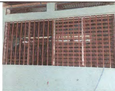
Foto 4: Sustitución de ventanas por ventanales de PVC, mantenimiento a balcones (lijado y pintado)
