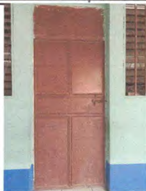
Foto 1: Mantenimiento (cepillado, lijado y pintado) de puertas.
