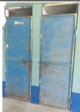
Foto 2: Mantenimiento de puertas (cepillado, lijado y pintado).
