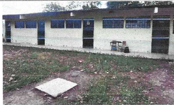
Foto 2: Losa de patio.
