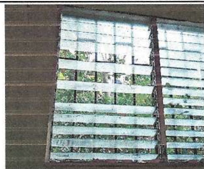
Foto 3: Sustitución de vidrios
