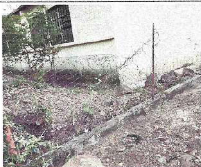
Foto 1: Reparación de muro perimetral.
