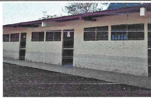
Foto 4: Pintura de muros interiores y exteriores
