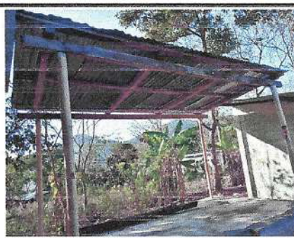
Foto 6: Sustitución de techo
