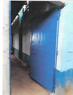
Foto 4: Instalación de puertas.
