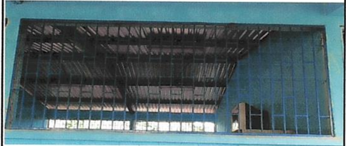
Foto 2: Sustrucción de ventanas por balcones parte frontal de aulas.
