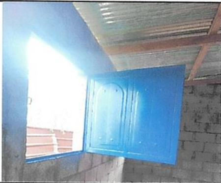
Foto 5: Instalación de ventanas.
