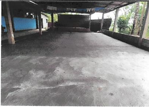
Foto 3: Ampliación de losa de patio.
