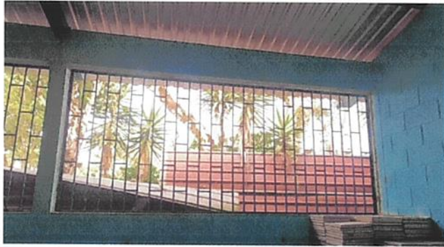
Foto1: Sustrucción de ventanas por balcones parte trasera de aulas.
