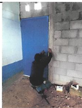
Foto 4: Instalación de puertas.
