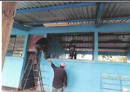
Foto 2: Sustrucción de ventanas por balcones parte frontal de aulas.
