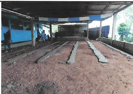
Foto 3: Ampliación de losa de patio.
