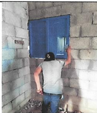
Foto 5: Instalación de ventanas.
