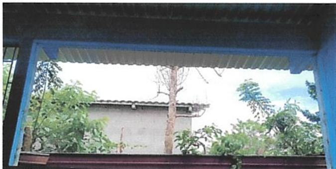
Foto 1: Sustrucción de ventanas por balcones parte trasera de aulas.
