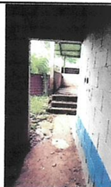
Foto 4: Instalación de puertas
