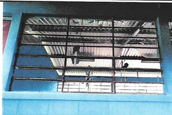
Foto 2: Sustrucción de ventanas por balcones parte frontal de aulas.
