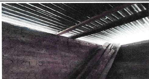
Foto 1: sustitución de estructura de madera por estructura de metal.
