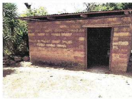
Foto 4: Losa de Cemento
