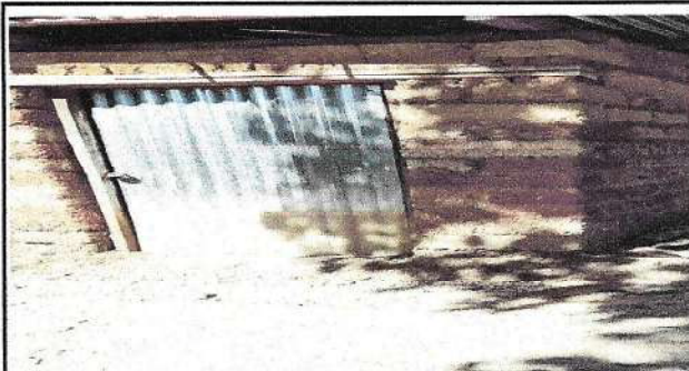
Foto 2: Sustitución de puerta de lámina por puerta de metal.
