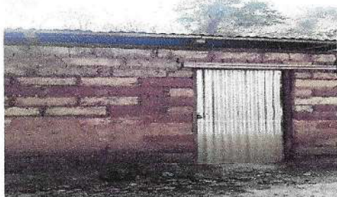
Foto 5: Reparación muro perimetral
