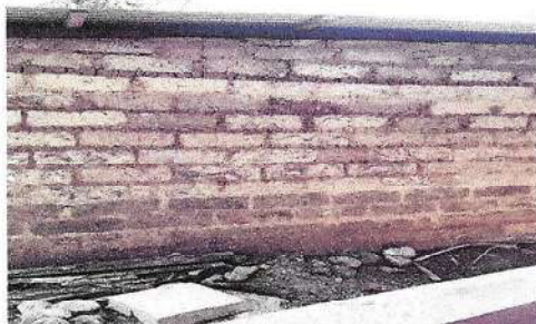
Foto 3: Reparación muro perimetral.
