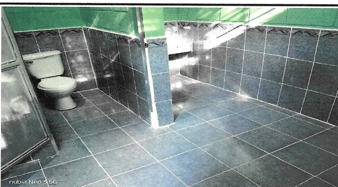
Foto 6: Reparación de Sanitarios
