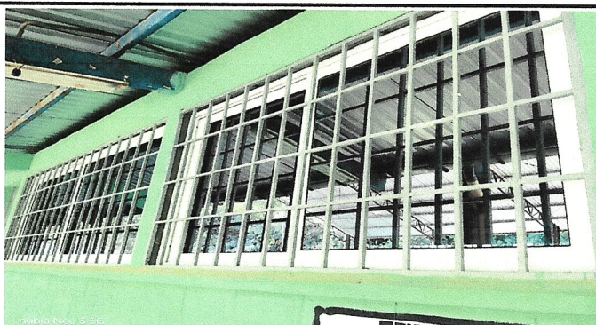
Foto 4: Sustitución de ventana
