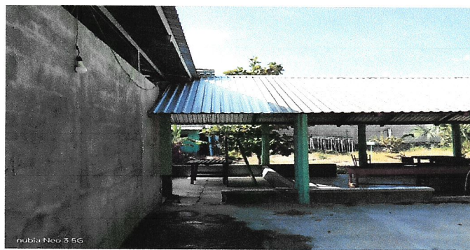
Foto 2: Estructura de techo
