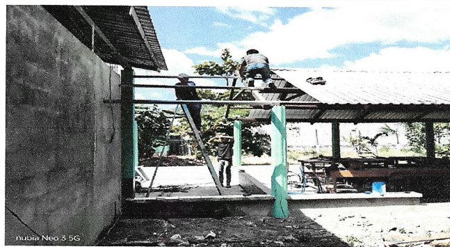
Foto 2: Estructura de techo
