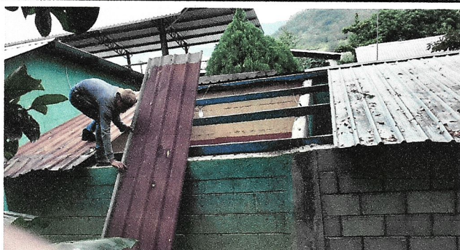
Foto 3: Cubierta de lámina
