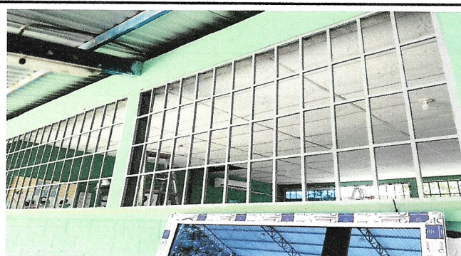
Foto 4: Sustitución de ventana
