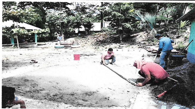
Foto1: Reparación de losa de patio
