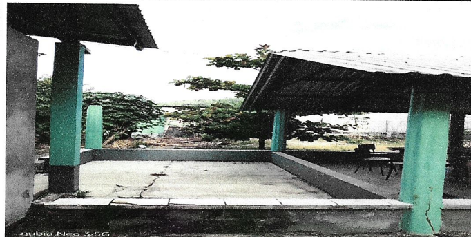
Foto 2: Estructura de techo
