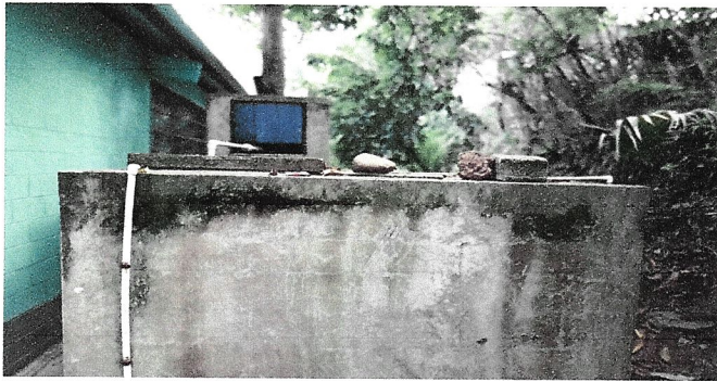
Foto 7: Depósito de Agua
