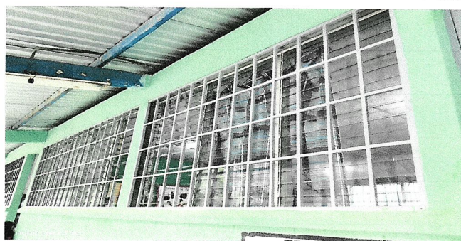
Foto 4: Sustitución de ventana
