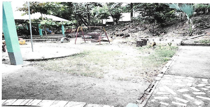
Foto 1: Reparación de losa de patio
