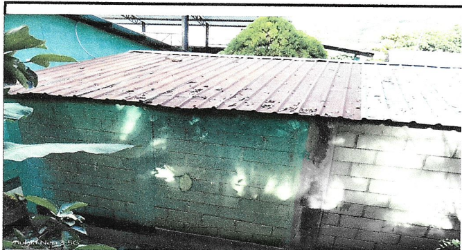
Foto 3: Cubierta de lámina
