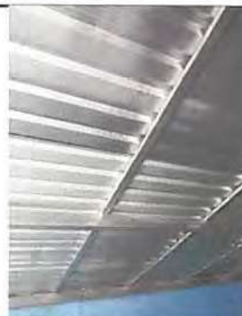
Foto 4: Sustitución de techo de cocina.
