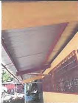
Foto1: Sustitución de lámina.
