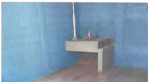
Foto 5: Reparación de área de cocina.
