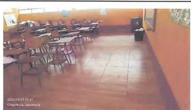
Foto 2: Instalación de cerámica antideslizante en tortas de cemento de aulas.
