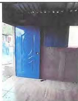
Foto 3: Instalación de puerta y ventana.
