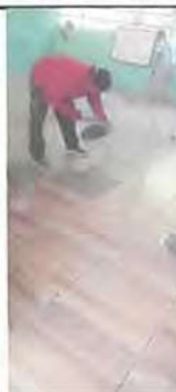
Foto 2: Instalación de cerámica antideslizante en tortas de cemento de aulas.
