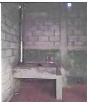
Foto 5: Reparación de área de cocina.
