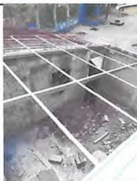
Foto 4: Sustrucción de techo de cocina.
