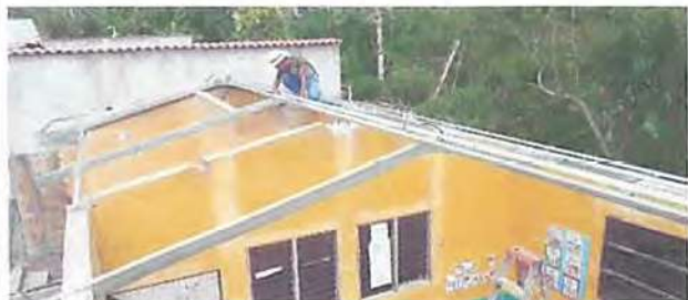
Foto 1: Sustrucción de lámina.
