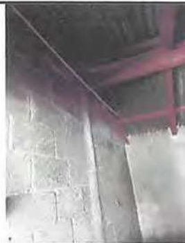
Foto 4: Sustrucción de techo de cocina.
