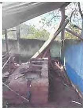
Foto 5: Reparación de área de cocina.
