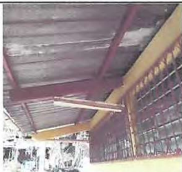
Foto1: Sustrucción de lámina
