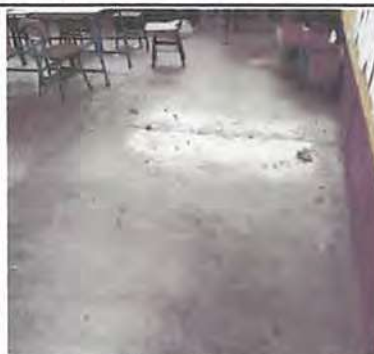
Foto 2: Instalación de cerámica antideslizante en tortas de cemento de aulas.
